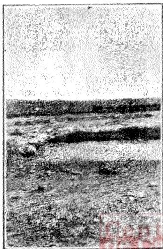
Restos de la construcción
